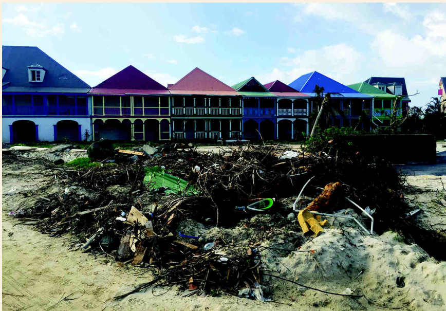
Figure 1 : Charpentes en site exposé ayant résisté
